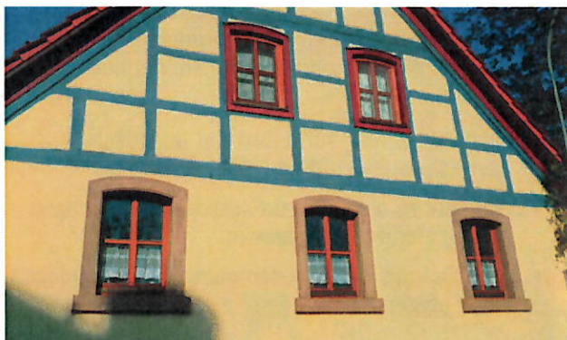
Sprossenfenster mit Steingewänden
