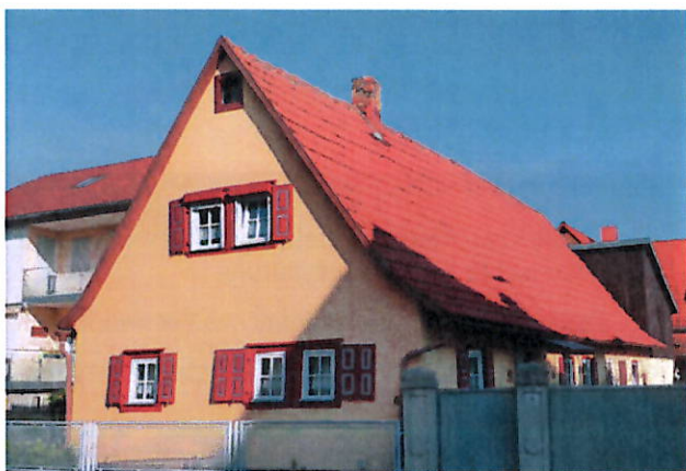
Sprossenfenster mit Fensterläden
