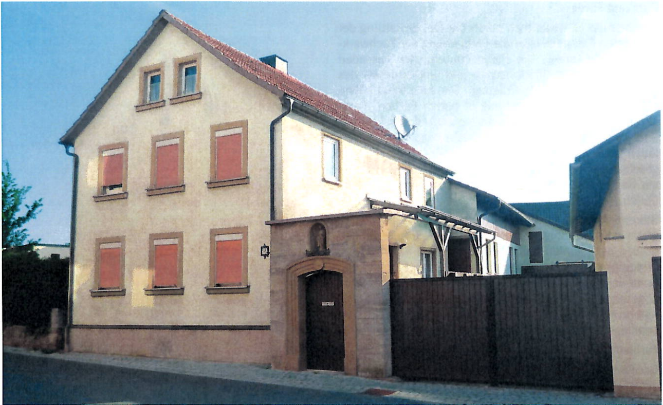
Anwesen mit Hofmauer, Eingangstor und Pforte
