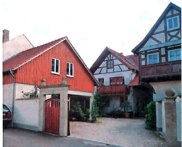
Hauptgebäude Fachwerk und Nebengebäude mit Holzverkleidung
