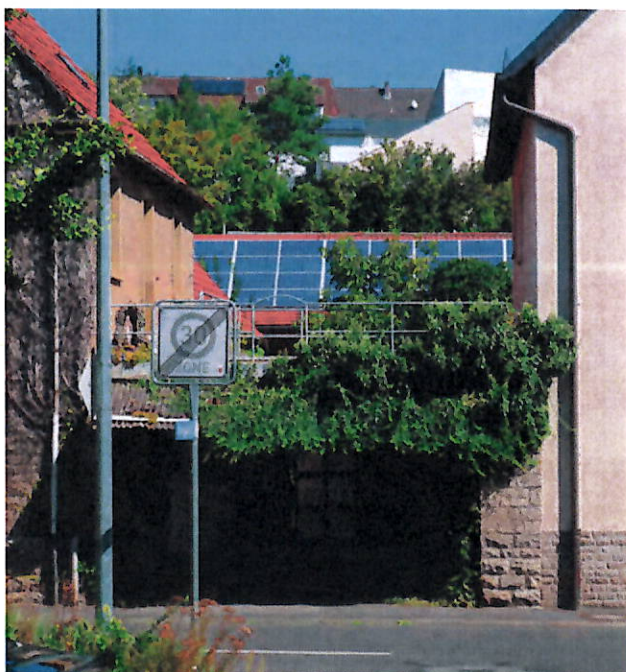
Beispiel für eine Photovoltaikanlage im Ortskern auf einem zurückgesetzten Scheunendach
