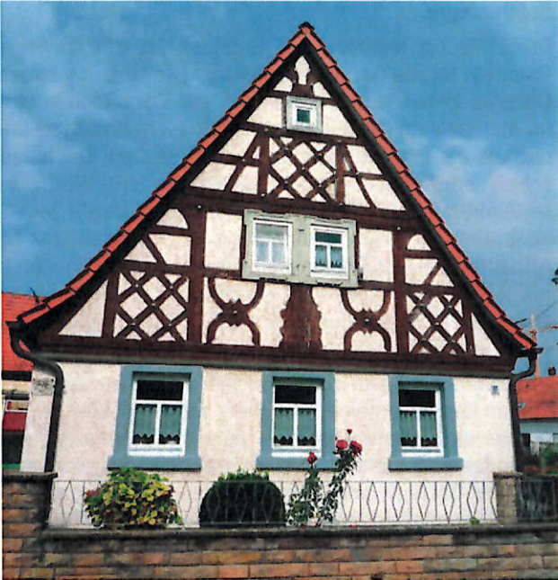
Ersgeschoss massiv, Giebel Fachwerk
