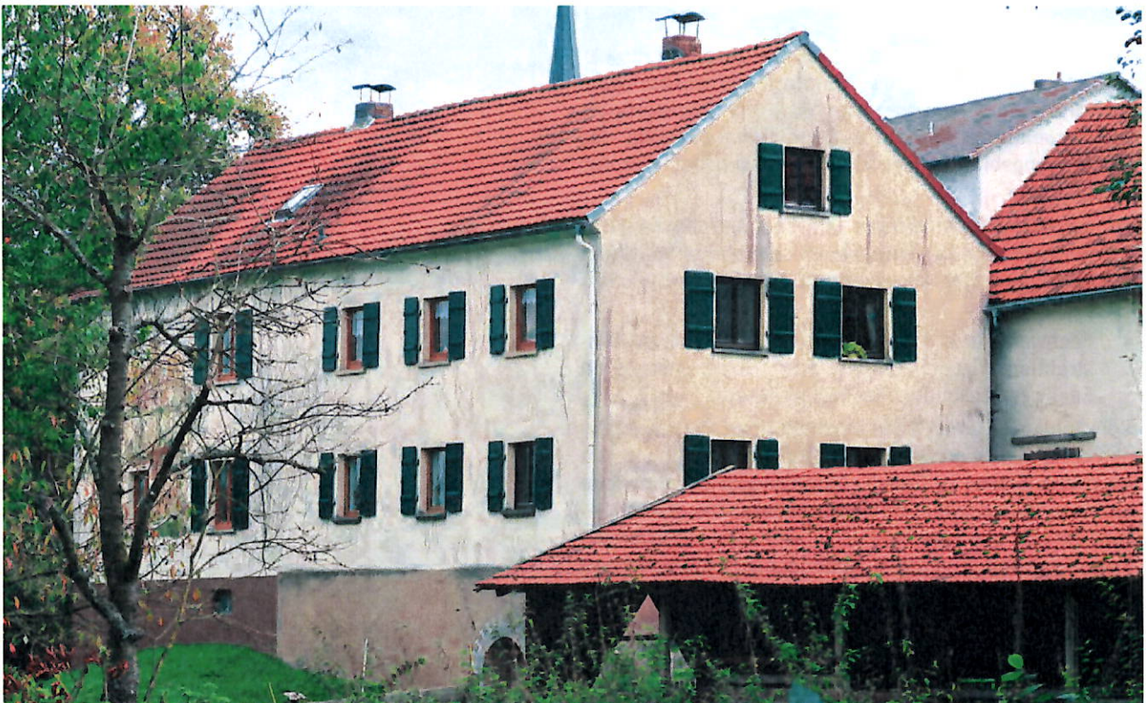
Traditionelle Lochfassade mit Fensterläden
