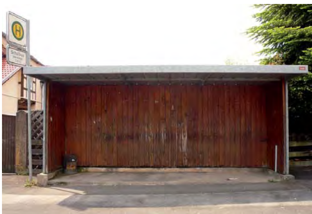
Bushaltestelle Bündstraße an der Westseite der Einmündung Bündstraße im Bestand
