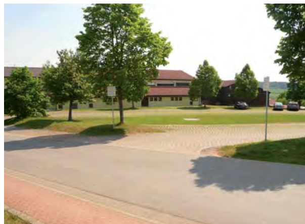
Freiraum südlich der Rudi-Erhard-Halle
