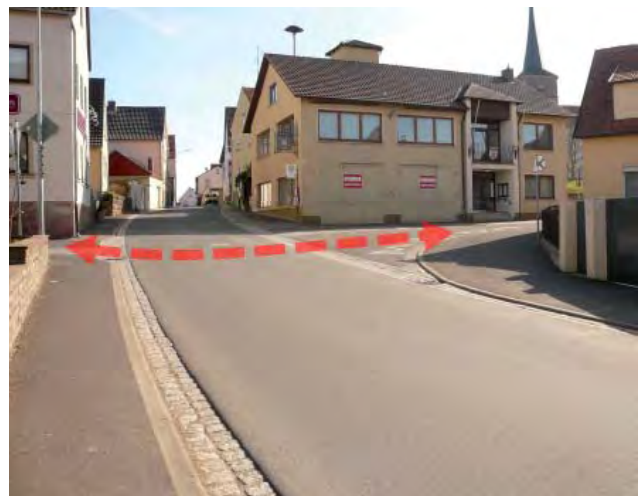
In der Münnerstädter Straße auf Höhe der Kirchstraße/Raiffeisenstraße weist keine Struktur im Straßenraum auf die hohe Bedeutung der Querbeziehung für Fußgänger hin (Schüler, Kirchgänger etc.)
