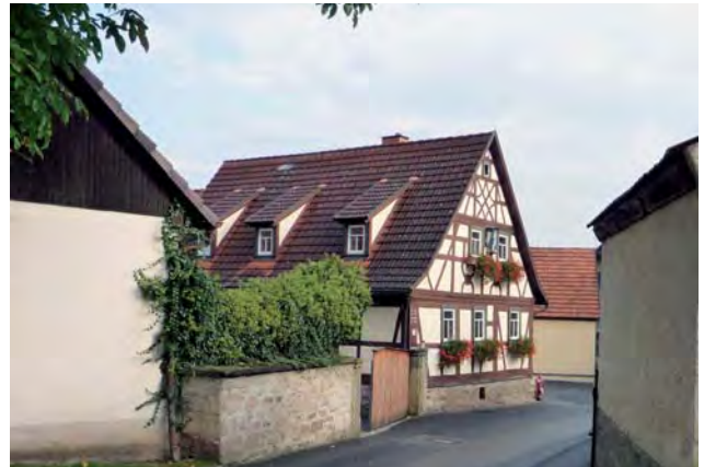
Fachwerkgebäude in der Kirchstraße
