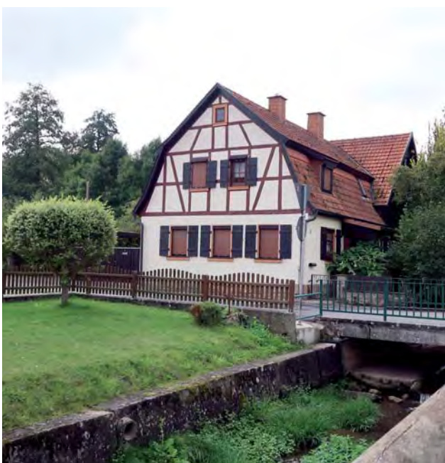
saniertes Wohngebäude am Reichenbach (Am Schlossberg)
