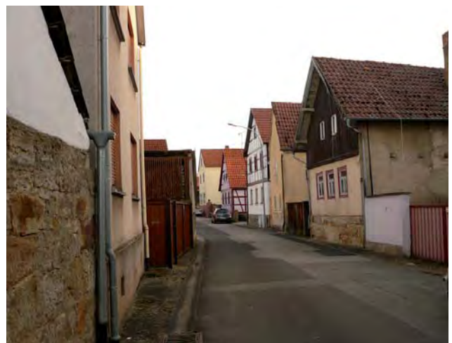
Ringstraße: bauliche Mängel und sanierte Wohngebäude, die sanierten Gebäude liegen außerhalb des Überschwemmungsgebietes
