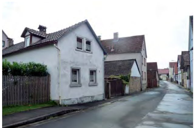
Bausubstanz in der Ringstraße
