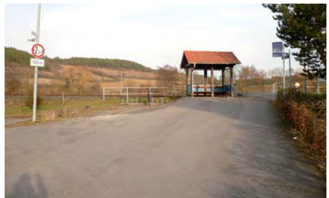
Bahnhaltepunkt mit Unterstand und Fahrradständer. Links außerhalb des Bildes befinden sich 7 P&R-Stellplätze.
