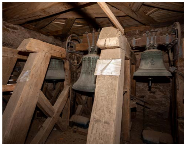
Der Glockenstuhl in der obersten Etage des Kirchturms.
