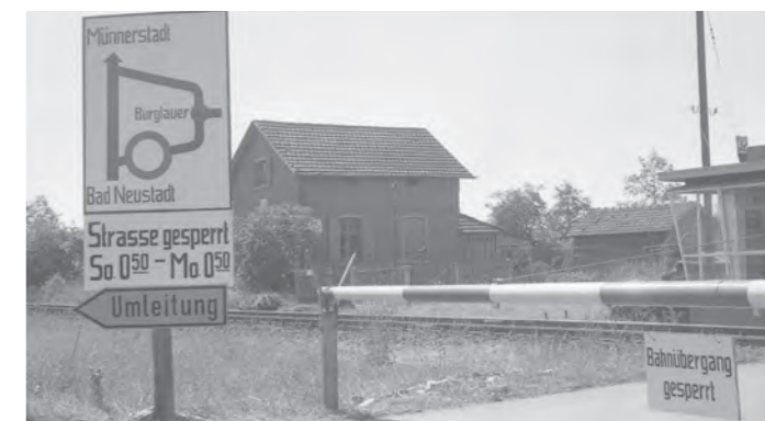
Der Bahnhofsposten 15, gegenüber der Höhbergsmühle, während der Brückenarbeiten im September 1964. Foto: Stadtarchiv Münnerstadt / Sammlung: Gerhard Fuhrmann
