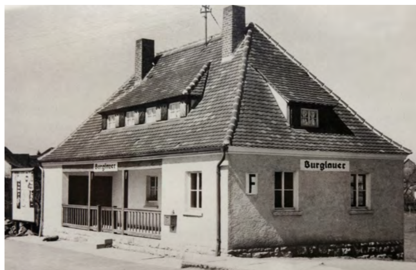
Das Bahnhofsgebäude in seiner Ursprungsform: In dem Raum an der Stirnseite des Gebäudes befanden sich der Schalter und der Warteraum. Foto: Rathaus Burglauer / Sammlung: 1100-Jahr-Feier
