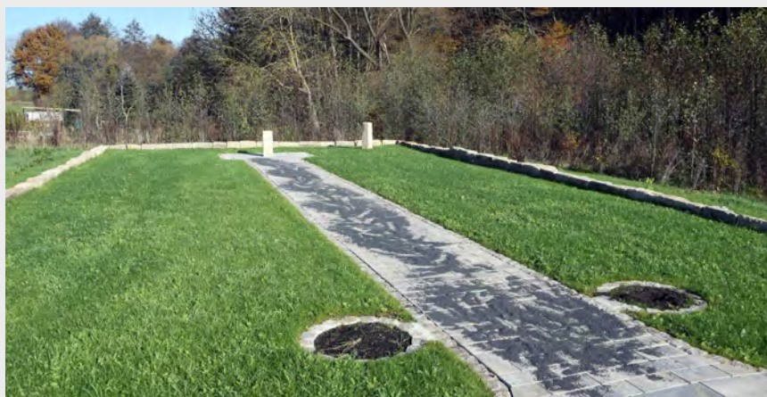
©"Trauplatz aktuelle Bauphase" von Jörg Endres
